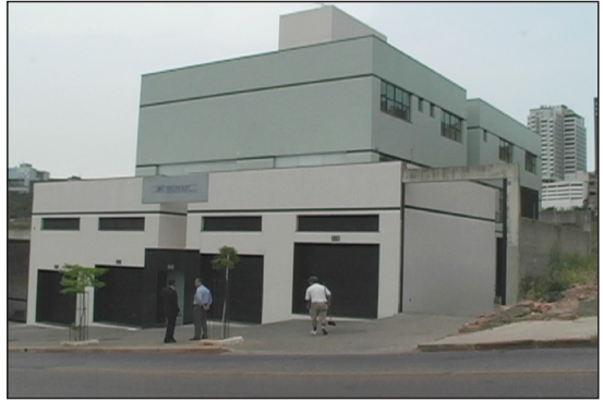
O edifício da TV em Belo Horizonte
